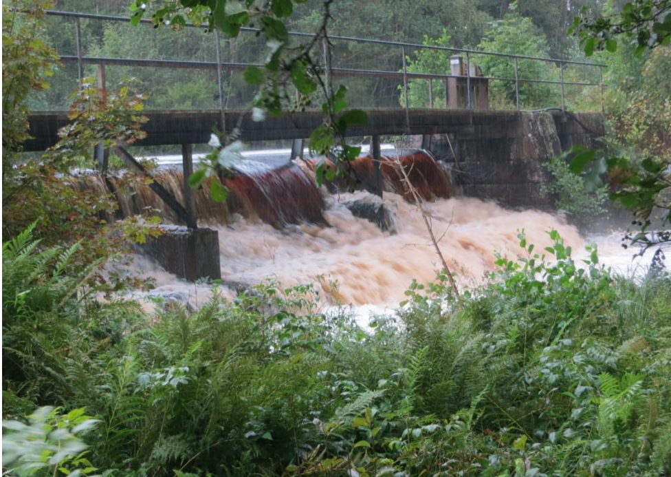
Figur 3.1 Utskovet som avbördar vatten till Klubbåns ursprungliga åfåra. Fotot är taget 2014-08-19. Flödet genom utskovet uppskattas till ca 4 m 3 /s.
