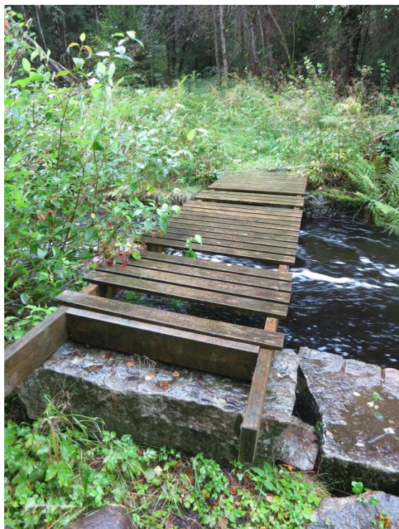
Figur 3.7 Klubbåns ursprungliga åfåra vid Rydöforsvägen 2014-08-19. Vid detta tillfället uppskattas flödet i åfåran till ca 4 m 3 /s.
