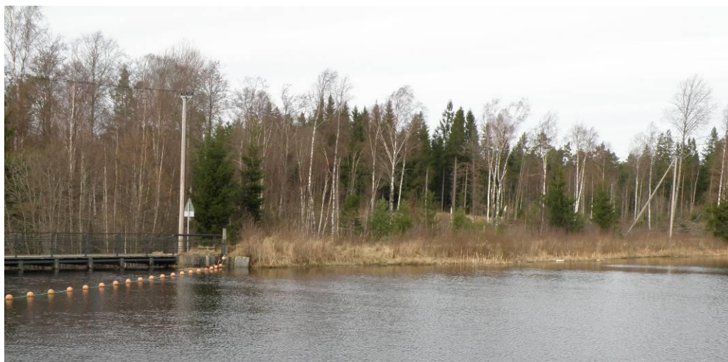
Figur 2.5. Del av fyllningsdammen vid Glassbo, ses till höger om regleringsdammen.
