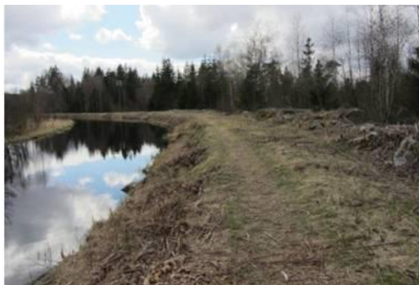
Figur 2.8. Delar av kanalvallen längs intagskanalen.
