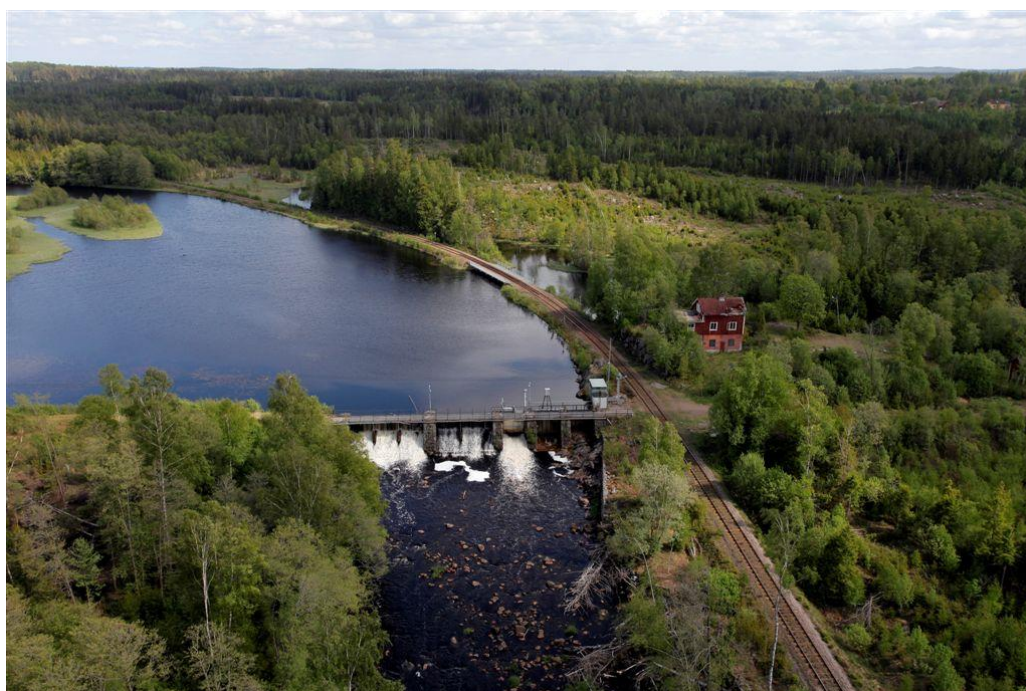
Flygfoto över Glassbodammen i Rydöbruk, nedströmsvy.
