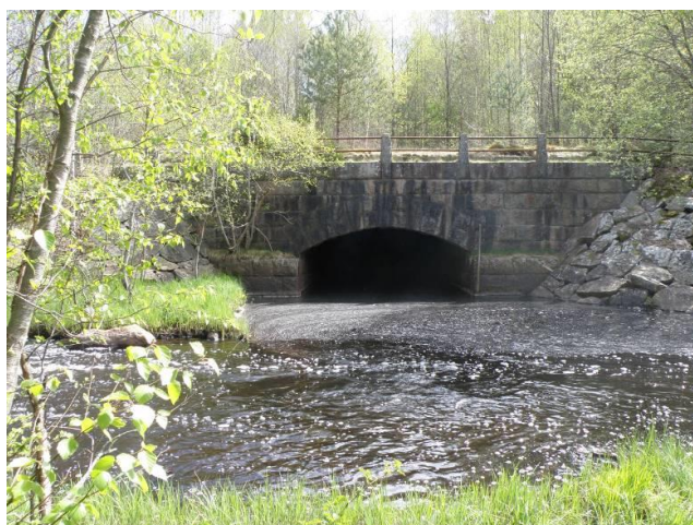
Figur 2.11. Utlopp från Rydö f.d. kraftstation.
