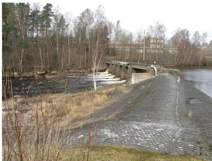
Figur 2.7. Sågverksdammen. Överfallsdamm (närmast i bild) samt utskovsdamm.
